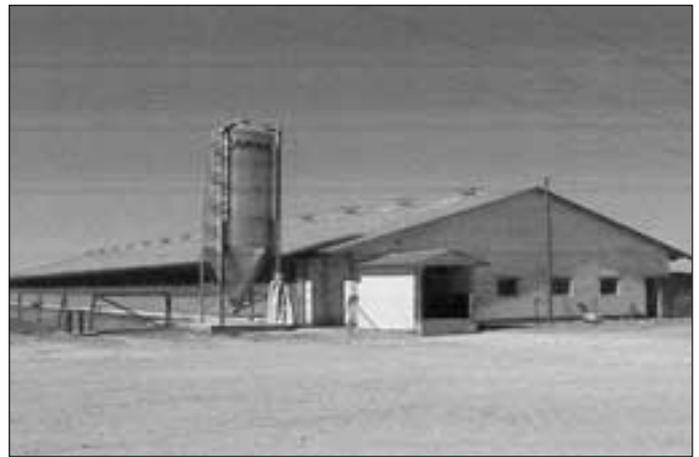
Bild 3: Offenstall mit langgezogenen, seitlichen Öffnungen (Nürtinger System)
