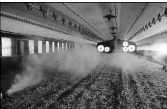
Bild 1: In die Giebelwand eingebaute Ventilatoren
