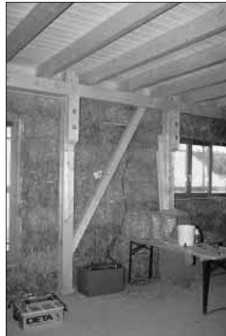
Bild 1: Mittelfristige Messungen (Temperatur und rel. Luftfeuchte) in einer Strohballenwand (Holzrahmenbauweise) in einem Haus in Junkershausen
