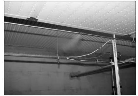
*Bild 2: Wasserversprühanlagen können die Stalltemperaturen um bis zu 5 K absenken.*
