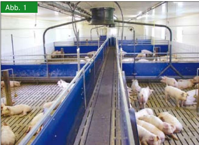
Versuchsabteil mit Hochdruck-Vernebelungsanlage zur Kühlung (Wasserleitungen mit Hochdruckdüsen zur Vernebelung sind seitlich über den Fenstern montiert)
