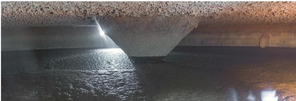
Abbildung 1: Blick in den Fermenter. Durch den mikrobiellen Abbau des Schwefelwasserstoffs lagert sich elementarer Schwefel an der Decke ab. © Universität Hohenheim/Landesanstalt für Agrartechnik und Bioenergie.
